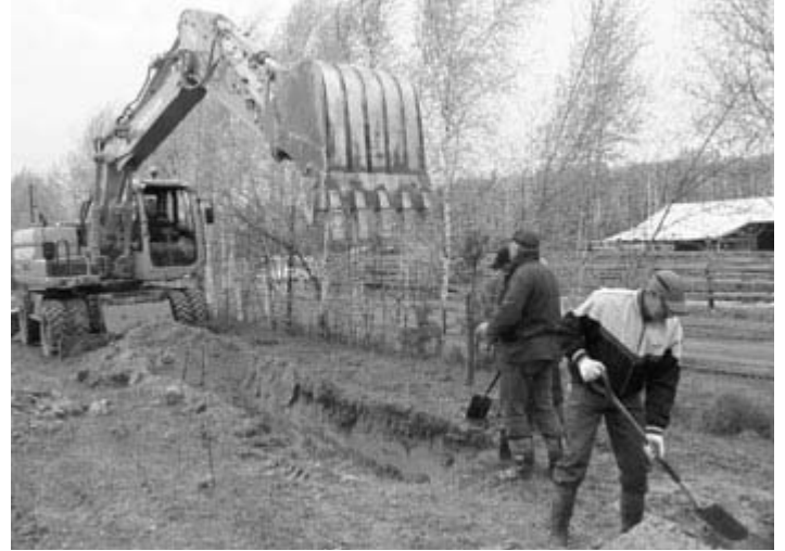
Początek układania wodociągu w Koźlikach
