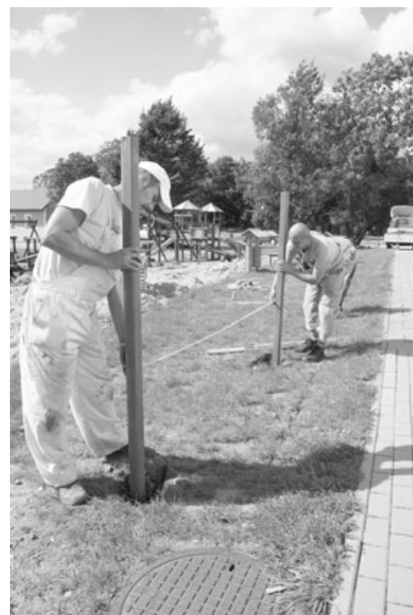
PW Robotnicy przy budowie ogrodzenia placu zabaw
