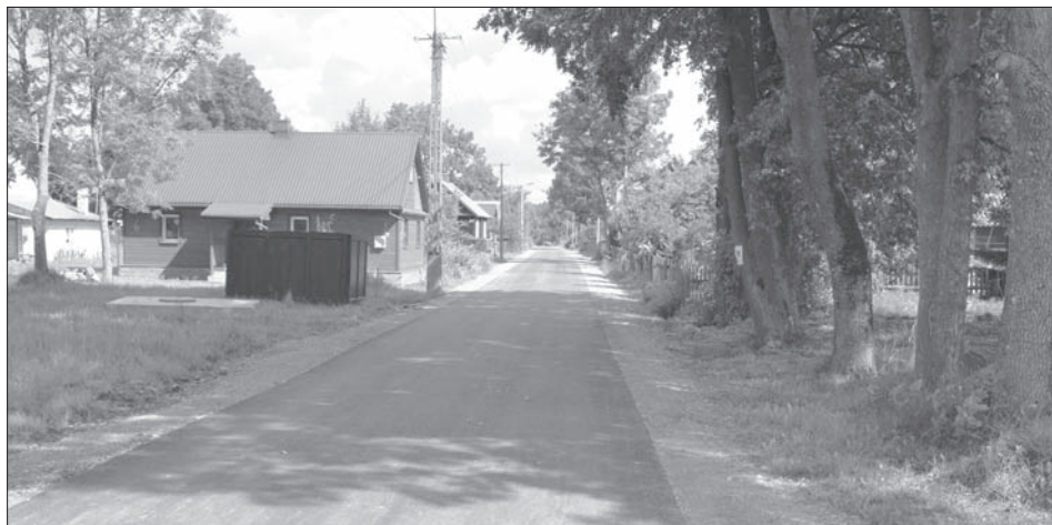
Uzupełniony fragment asfaltu w Pasyńkach
