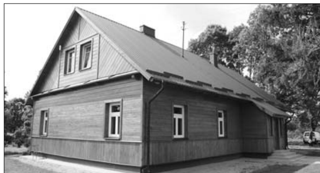
Przy świetlicy wiejskiej w Zwierkach powstanie biologiczna oczyszczalnia ścieków
