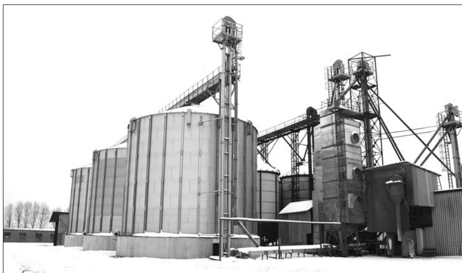
W tych ogromnych silosach składowana jest kukurydza, rzepak i zboża
