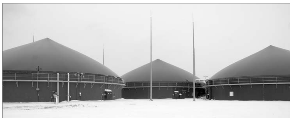
Trzy, betonowe silosy bioelektrowni w Rybołach
